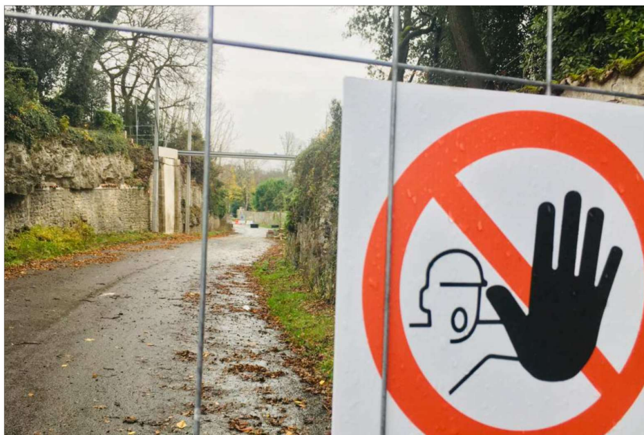
Le bloc de pierre de 50 tonnes s'est effondré en février dernier, suite à de fortes précipitations.
